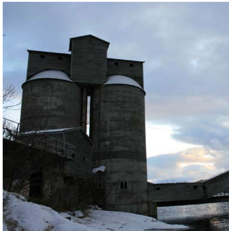
Her planlegger Knut Wilhelmsen å bygge fritidsleiligheter.
