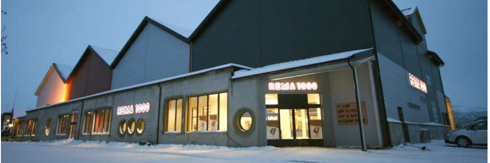
Ferdigstillingen av REMA-bygget stoppet opp etter konkursen i Bendiktsen&Aasen. Nå lover utbygger at arbeidet blir gjenopptatt på nyåret. Foto: Jon Henrik Larsen
